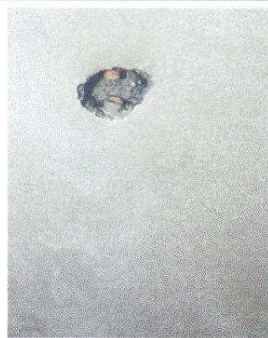
Foto 7. Reparación del sistema eléctrico
