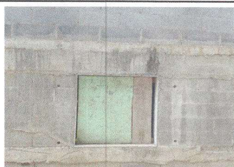
Foto 2. Sustitución de ventanas de madera por metal mas vidrio
