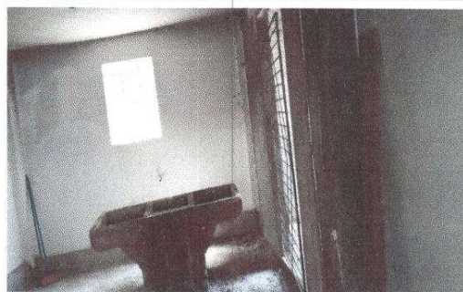
Foto 10. Sustitución de tubería, chorro y pila
