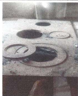
Foto 11. Sustitución de plancha de metal de 3 hornillas
