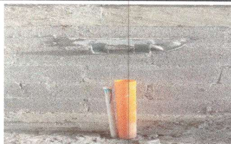
Foto 12. Instalación de lava trastos
