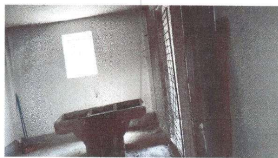
Foto 4. Pintura de muros exteriores e interiores
