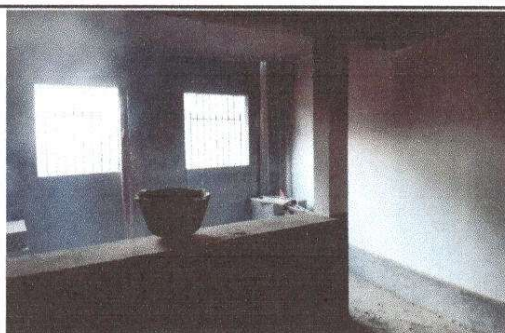
Foto 9. Repello y pintura en muros exteriores e interiores
