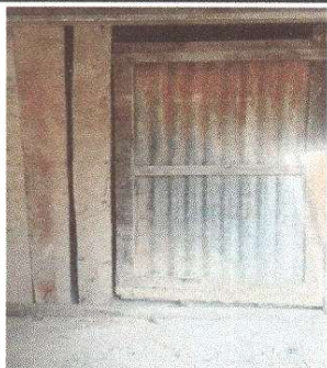
Foto 1. Sustitución de portón de metal
